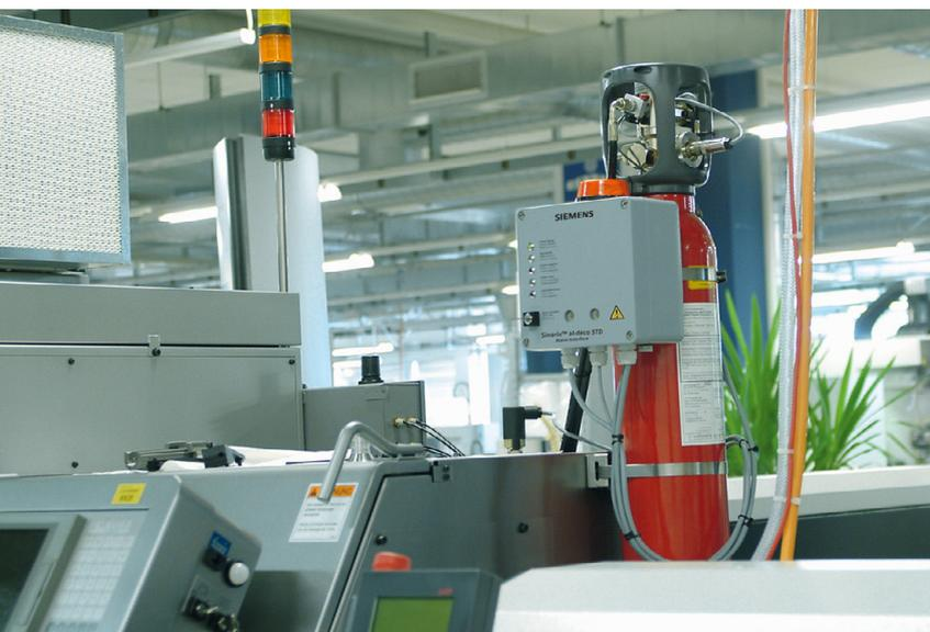
I sistemi di protezione d'oggetto Sinorix al-deco STD sono già stati installati su migliaia di macchine utensili.
